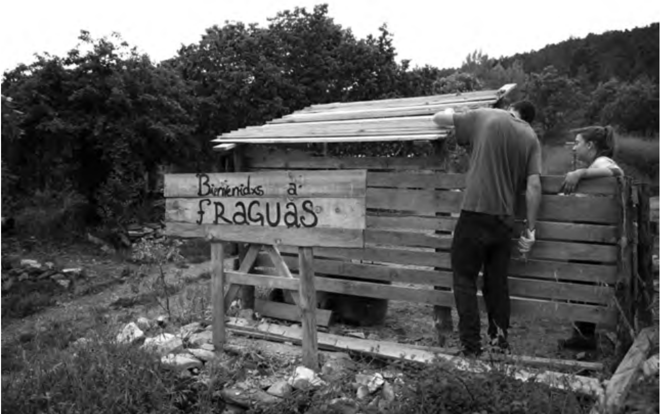
■ Dos repobladores trabajan en la construcción de un cuarto para la basura en Fraguas. David Folgueiras
